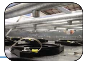
DETALLE TUBO SOPLADOR
